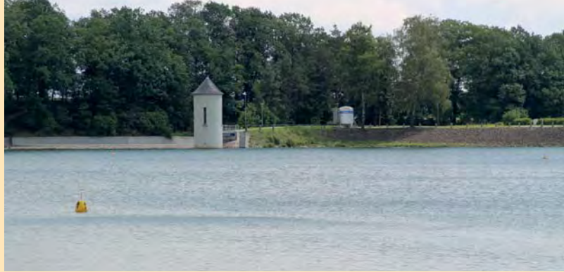
Entnahmeturm und Überlaufbauwerk, im Hintergrund der Sauerstofftank.
